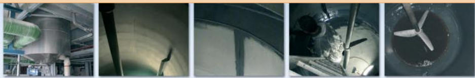
Mechanické odstranění koroze a vysušení vnitřního povrchu
